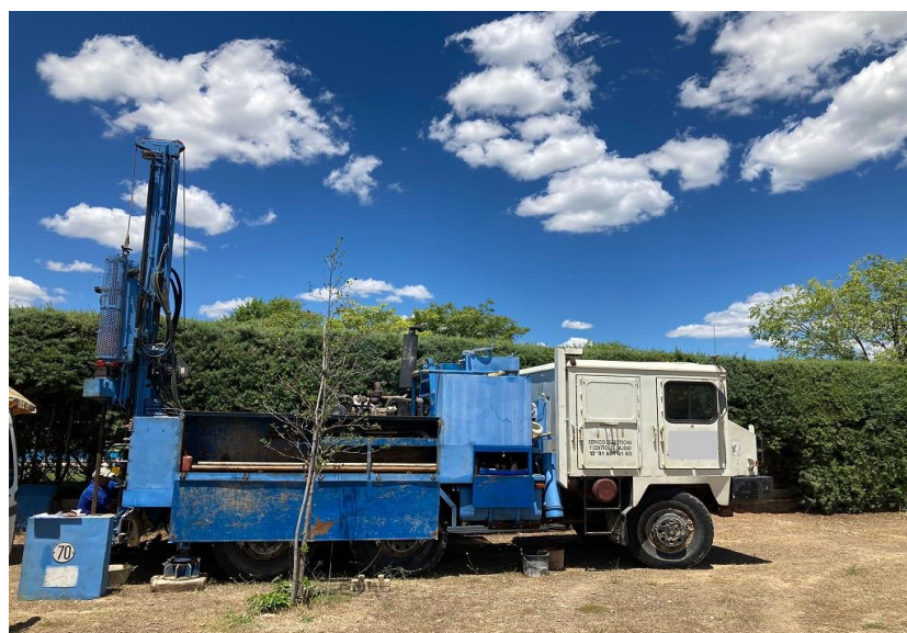
Figura Nº 2.- Imagen de la ejecución del sondeo mecánico y rotativo con extracción continua de testigo referido como S-01.
