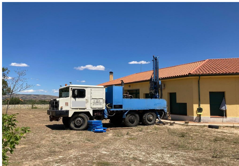
Figura Nº 3.- Imagen de la ejecución del sondeo mecánico y rotativo con extracción continua de testigo referido como S-02.
